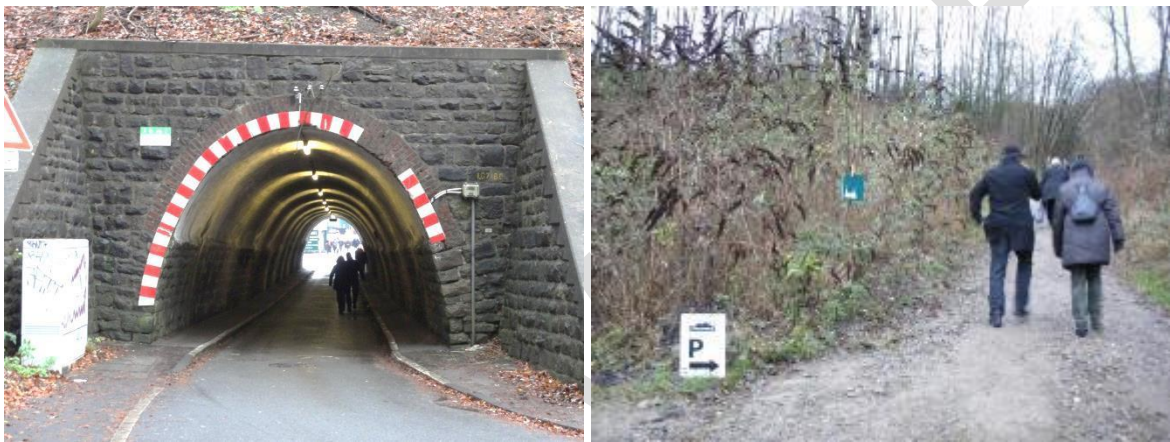
Bild 70: Gefahrenstelle Tunnel Nordbahntrasse (links), Fußweg zum Schloss (rechts) (Quelle: Bergische Universität Wuppertal, Straßenverkehrsplanung und Straßenverkehrstechnik)
